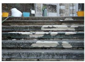
Decoesione, lesioni e/o cavillature di intonaco Per ripristinare l'adesione fra lo strato di finitura e la muratura si è proceduto alle operazioni di consolidamento mediante iniezioni di malta fluida tipo Ledan TA1 e/o TA 2 in relazione ai casi riscontrati. Laddove necessario si è provveduto al rifacimento degli intonaci nelle aree lacunose e alla ricostruzione delle parti modanate mancanti e/o degradate.
