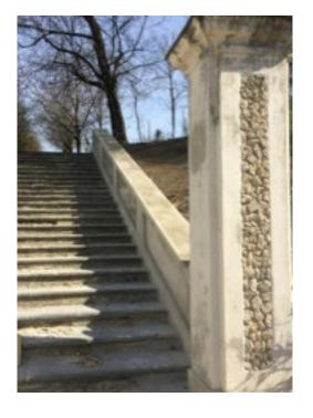
Danni strutturali a causa della vegetazione La prima lavorazione effettuata è stata quella relativa all'abbattimento dell'albero (Celtis) a destra del parapetto della scala verso il "viale dei Carpini". L'apparato radicale aveva, infatti, gravemente danneggiato la balaustra a tal punto da procedere con la demolizione della porzione centrale e al suo ripristino successivamente alle operazioni di consolidamento.
