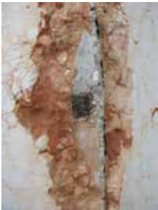
9,10. Fenomeni di ossidazione degli elementi di ancoraggio.
