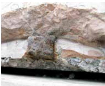
9,10. Fenomeni di ossidazione degli elementi di ancoraggio.
